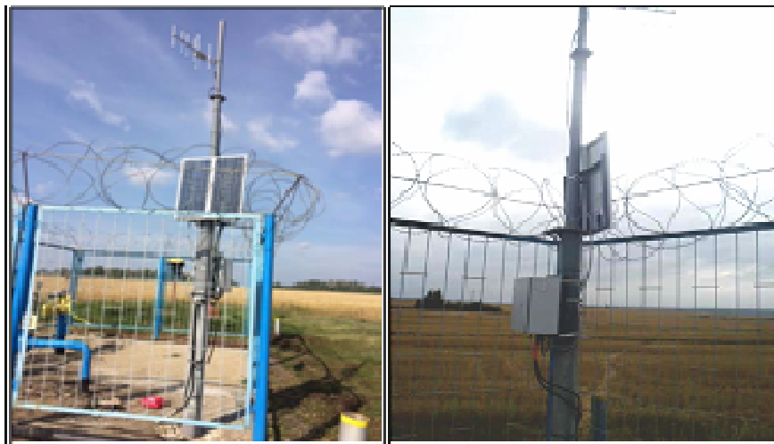
Рисунок 8. Обеспечение автономным питанием от солнечной батареи радиомодема и кранового узла
