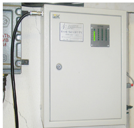
Пример размещения Шкафа КШ в здании ГРС
