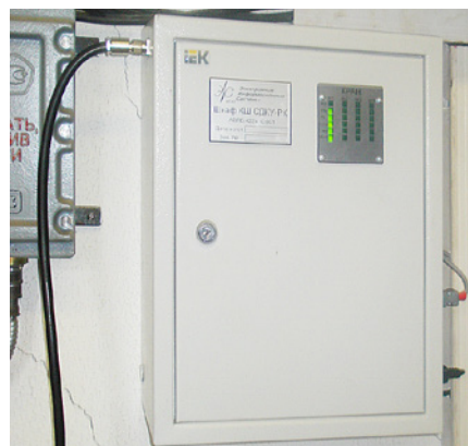
Пример размещения Шкафа КШ в здании ГРС
